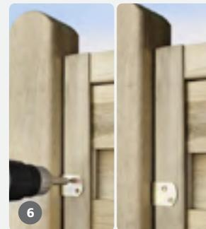
Setzen Sie nun die Zaun-elemente ein und fixieren diese, nachdem Sie die Schraublöcher vorgebohrt haben. Mit zwei Personen ist diese Arbeit, auch ohne Unterlegholz, einfacher zu meistern. Achten Sie auf den gleichmäßigen Pfosten-/Zaunelementabstand von 1 cm, eine gleichmäßige Höhe und die passende Flucht der Zaunfelder.
