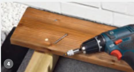
Terrassendielen im rechten Winkel zur Unterkonstruktion ausrichten. Bitte achten Sie auf ausreichend Abstand zu festen Bauteilen wie Wänden. Es sind zwei Verschraubungen je Brettbreite pro Kreuzpunkt mit der Unterkonstruktion erforderlich. Wir empfehlen Ihnen, vor dem Schrauben mit einem Bohrer mit Senker vorzubohren.
