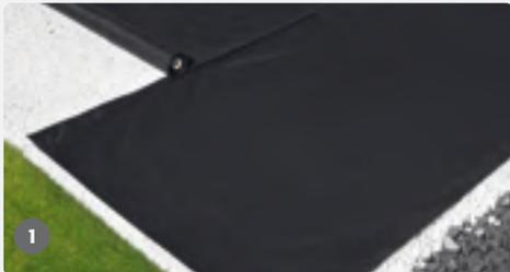
Als ersten Schritt legen Sie eine ebene Fläche an. Anschließend wird eine grobe Schotterschicht (20-40 cm) und eine anschließende Kiesschicht (5 cm) auf der Fläche verdichtet. Bitte beachten Sie, dass die Fläche ein Gefälle von ca. 1-2 % haben muss. Es wird empfohlen, zusätzlich ein Unkrautvlies als Schutz zu verlegen.
