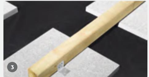
Unterkonstruktion hochkant und mittig auf die Steinplatten legen und an mindestens drei Punkten mit Metallwinkeln befestigen. Je nach Holzart und Stärke der Terrassendiele sollte der Abstand der Unterkonstruktion zwischen 20 und max. 50 cm liegen.
