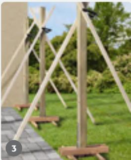
Diagonale Latten helfen Ihnen, den Pfosten exakt in Höhe und Lot auszurichten. Fixieren Sie diese entweder mit einer Schraubzwinge oder mit Schrauben. Durch den Einsatz einer Spannschnur erreichen Sie, dass alle zu setzenden Pfosten in einer Flucht und gerade stehen. Anschließend füllen Sie das Fundamentloch mit Beton. Empfehlenswert ist B25 Fertigbeton, der vorab gründlich angerührt wird.
